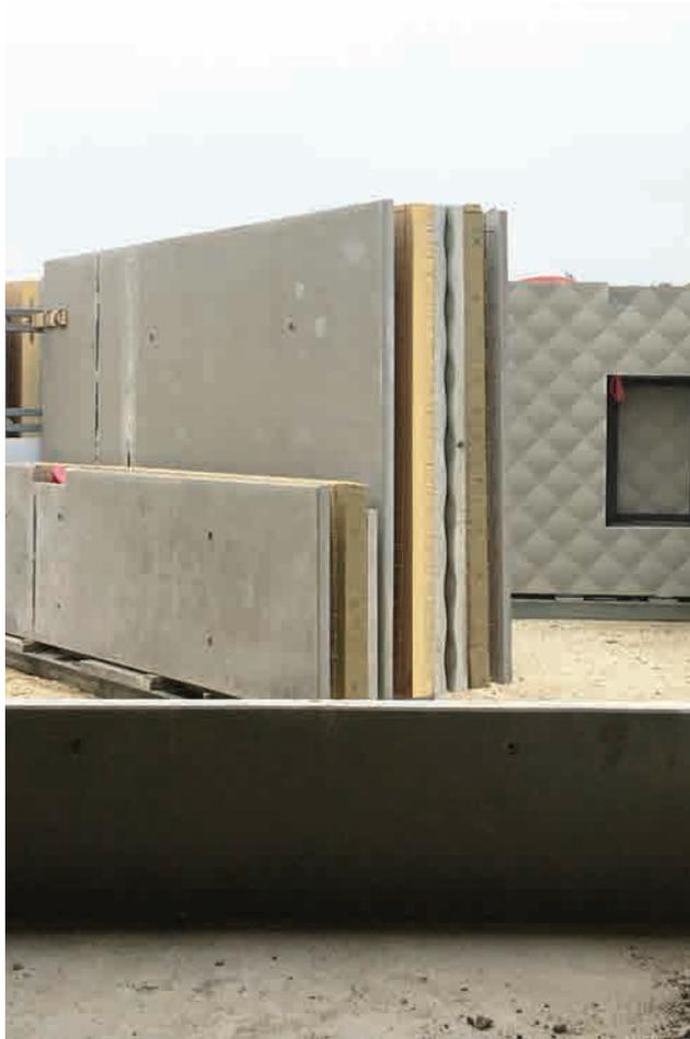
*FAÇADE PRÉFABRIQUÉE : BÉTON BILAME
